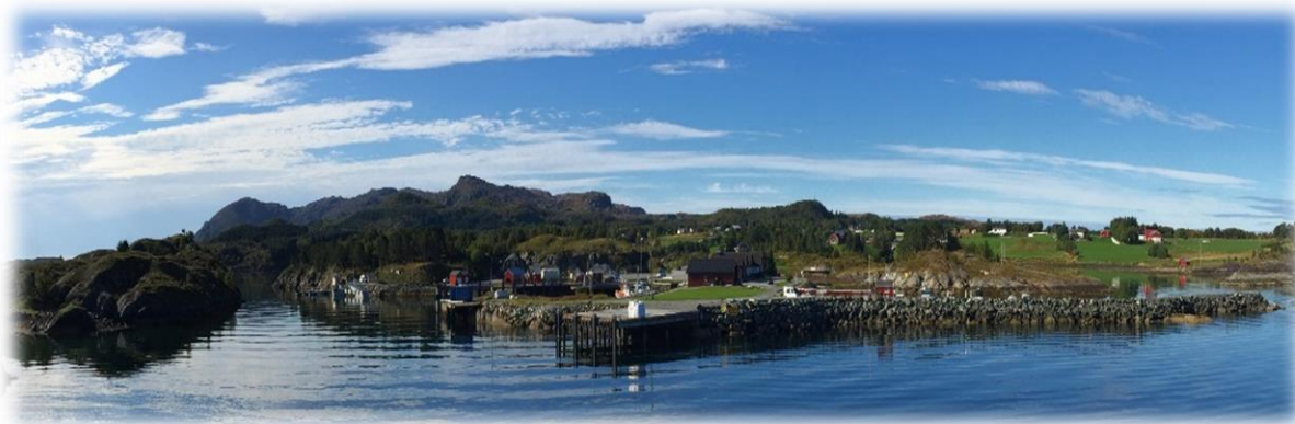
Bilde 6 - Dagens område sett fra sjøsiden – atkomst sjøveien til Leka
