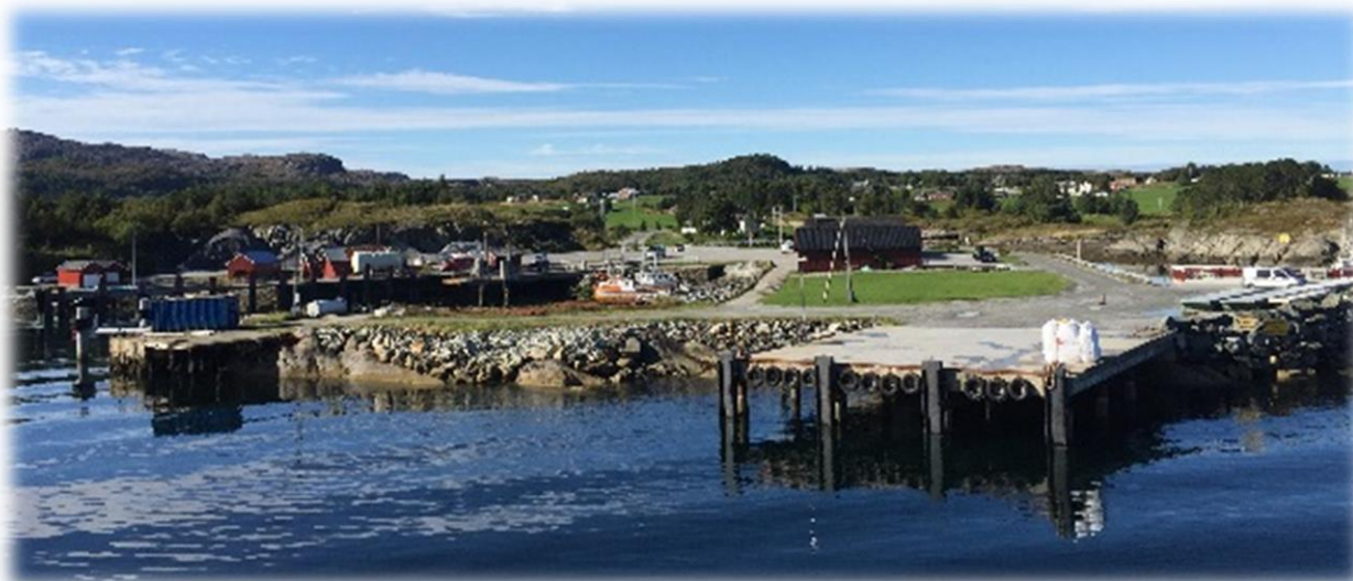
Bilde 12 Dagens næringskaia – vurderes utbedret og utvidet for anløp av større båter
