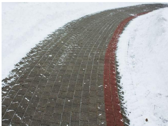
Figur 3031- gangsti med snø-smelteanlegg, kilde ukjent
