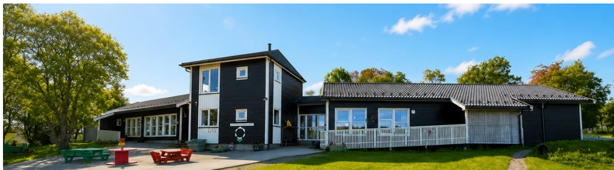
Ny barnehage ferdigstilles februar 2018
