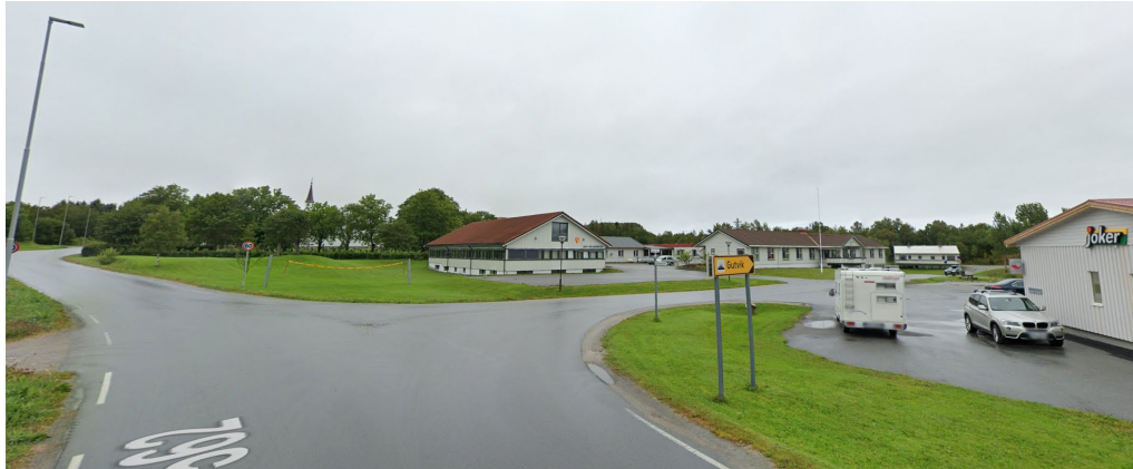
Oversiktsbilde over Krysset Skeisveien-Leknesveien-Frøvikvein, sett fra Frøvikveien.
