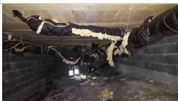
Bilde 16: mineralull som rørisolasjon.
