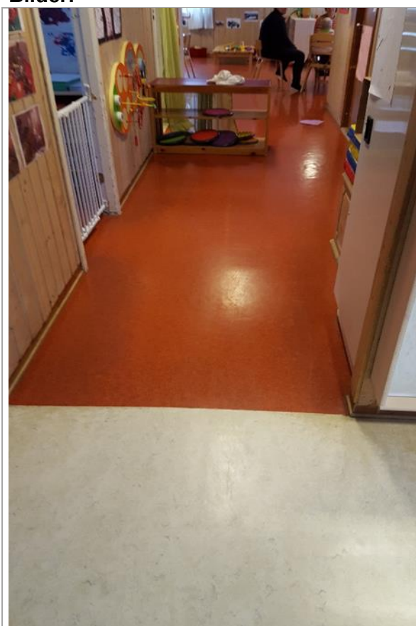
Bilde 3: Gulvbelegg i storbarnsavdeling, ikke prøvetatt. Antas å inneholde ftalater over grensen for farlig avfall pga. alder.
