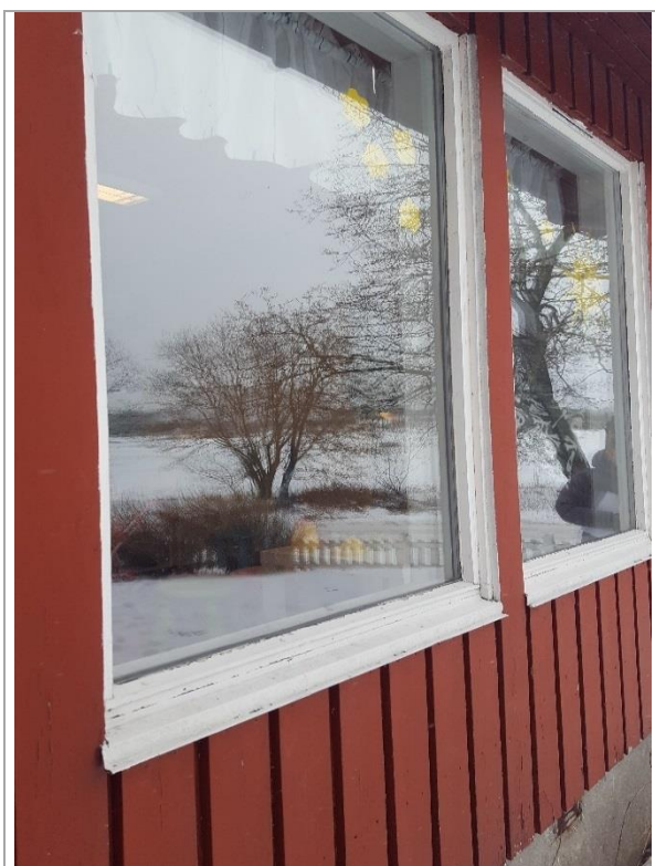
Bilde 5: Vinduer fra 1977-1978
