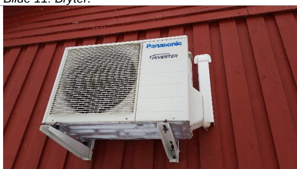
Bilde 13: Varmepumpe.
