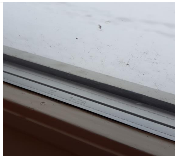
Bilde 1: Vindu fra 1978.
