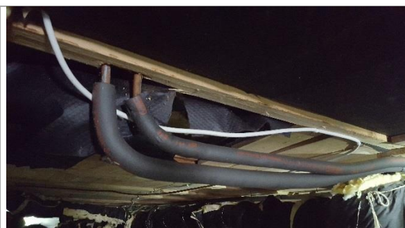
Bilde 8: Kobberrør med cellegummi som isolasjon.
